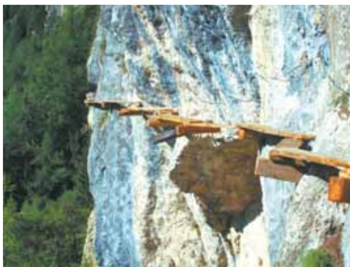
Par endroits, les planches sont posées en zigzag, suivant la géométrie de la falaise. Au centre, une poutre de 1415, légèrement inclinée avec le temps.
